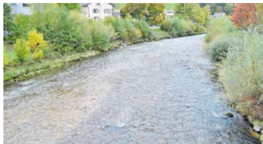
Unterhalb der Postbrücke in Wattwil wird eine Mauer, die wie ein Nagelfluhfels aussieht, als Uferverbauung erstellt. Bild: Sabine Camedda
