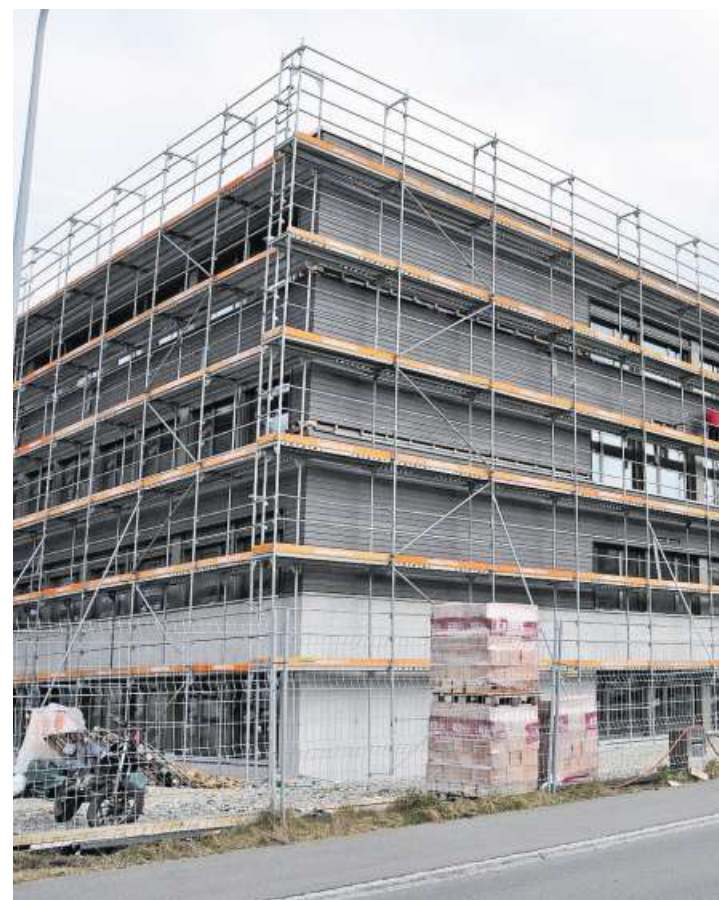
Die Bauarbeiten bei der Schulanlage Wier in Ebnet-Kappel laufen trotz Coronavirus weiter. Bild: Sabine Camedda
